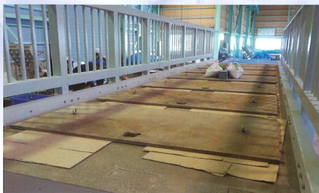
鋼板載荷状況
