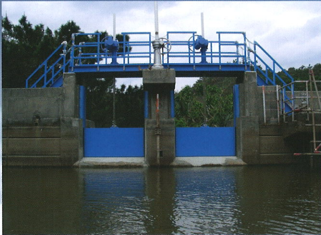
水 門 ・ 操 作 橋
