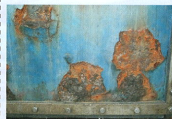
鋼製水門(扉体部拡大)
