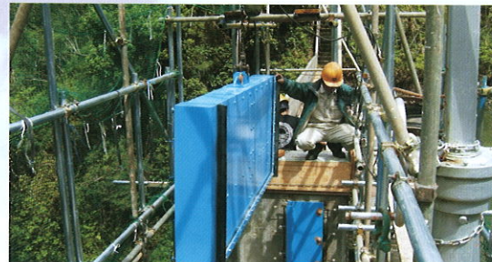
簡易施工器具のみによる施工状況
